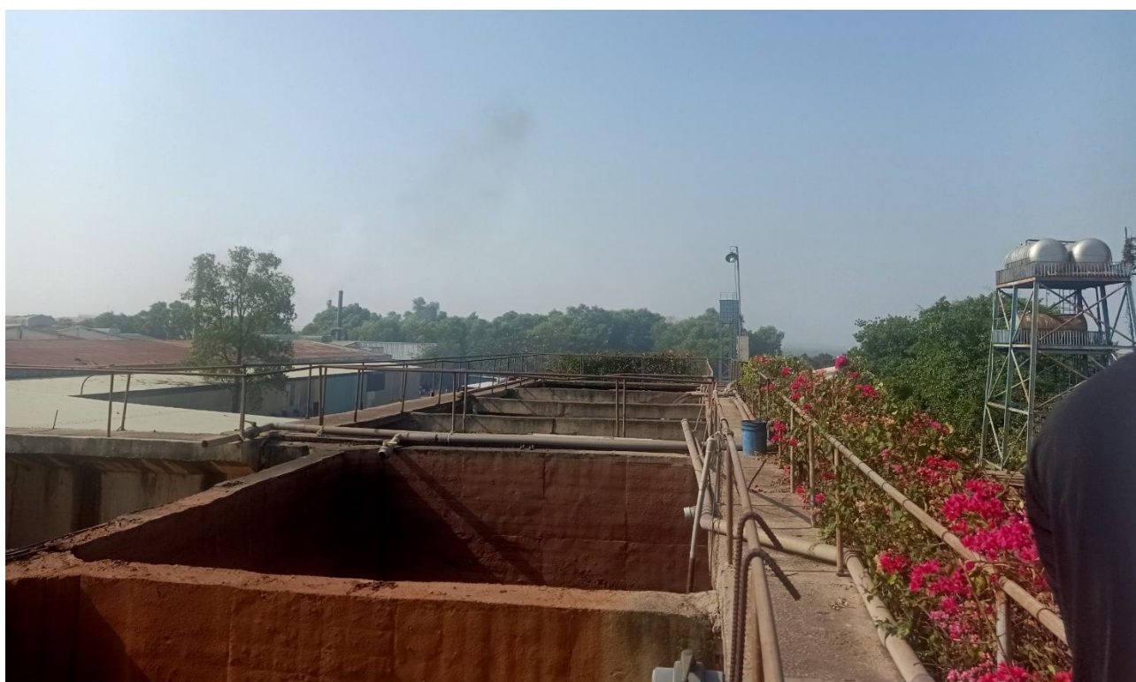
Hình 3.18. Hình ảnh thực tế bể chứa nước thải thể tích 1.869m 3
