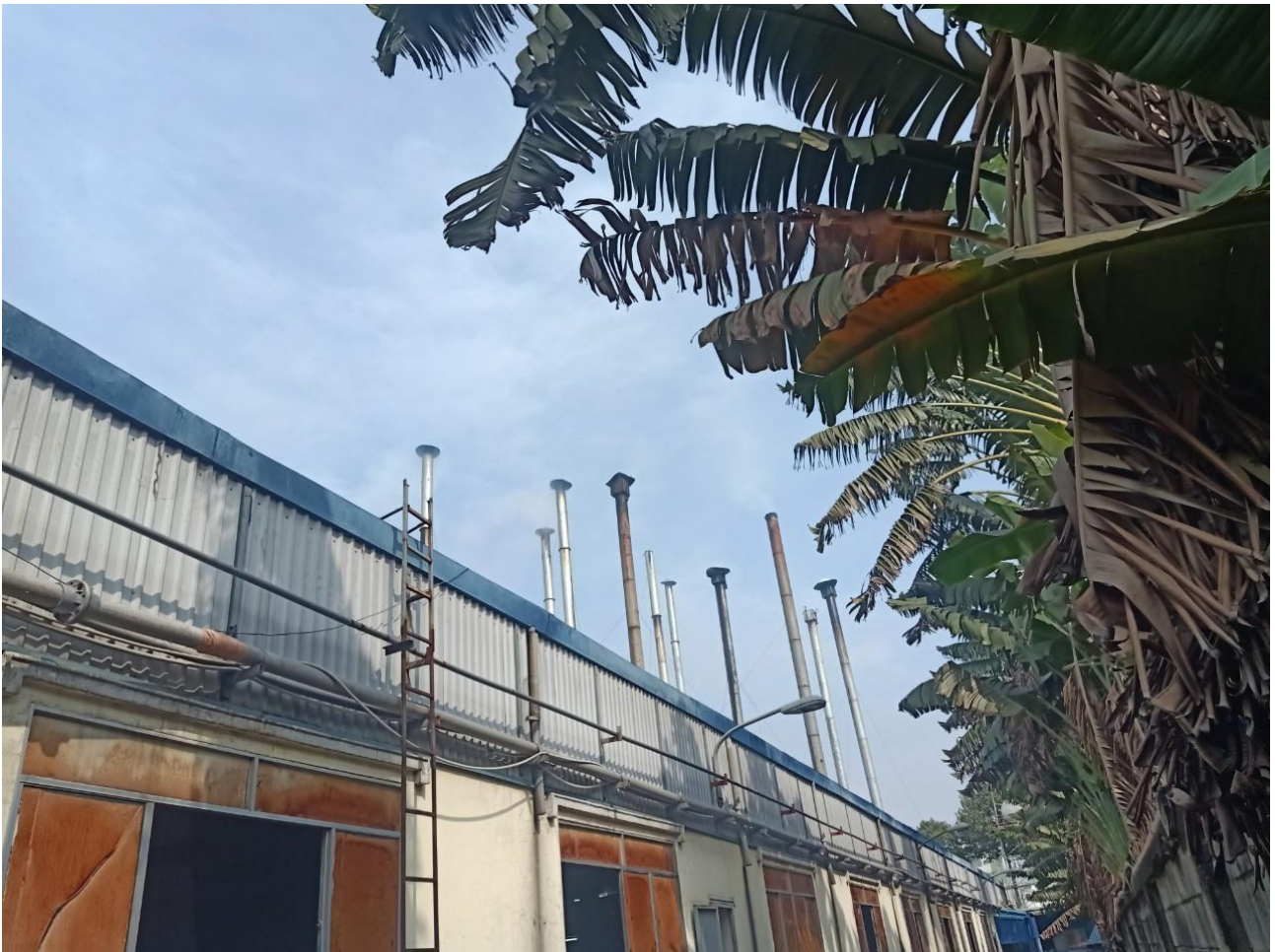
Hình 3.15. Ống thoát khí thải máy Tenter (hình ảnh thực tế)
